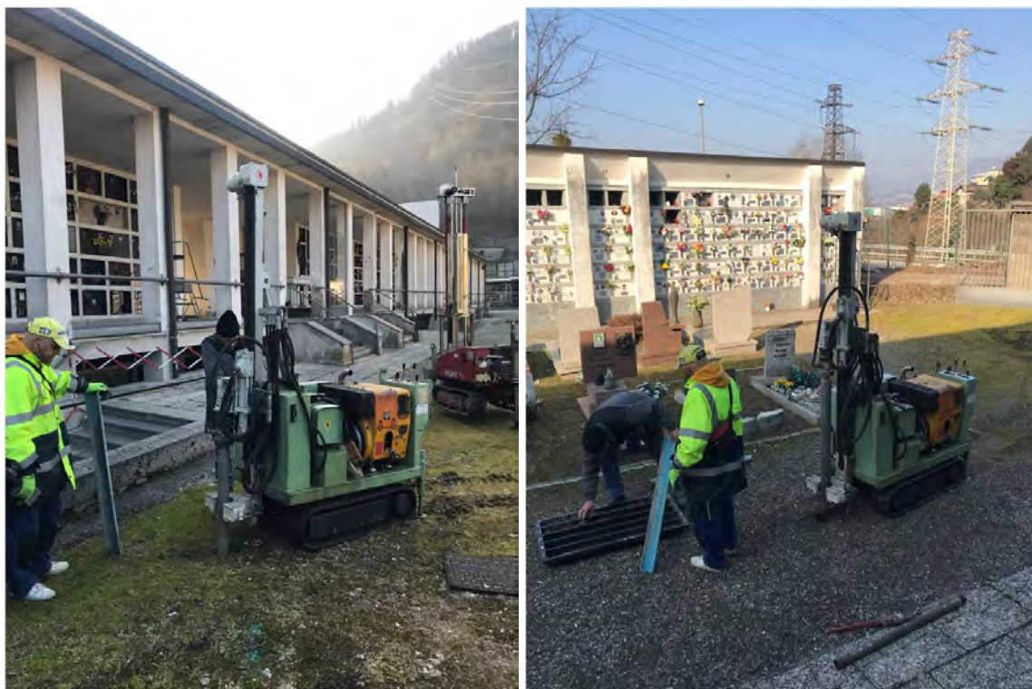
Esecuzione dei sondaggi.
