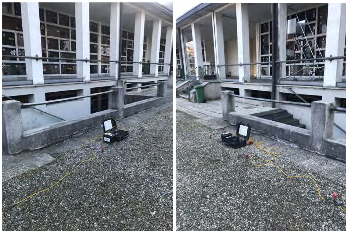
Esecuzione della prova sismica MASW.
